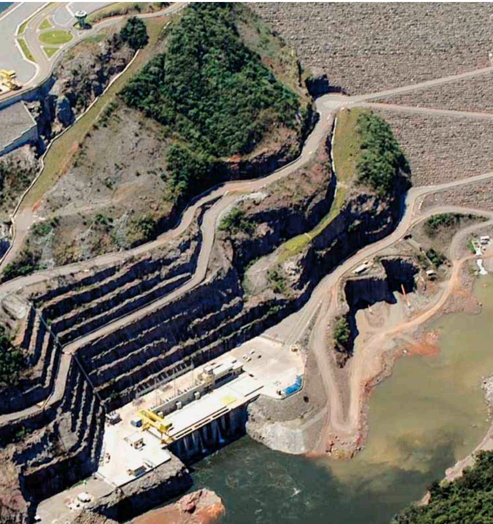
San Antonio Hydroelectric ist eine der größten neuen Anlagen zur Energieerzeugung in Brasilien.
